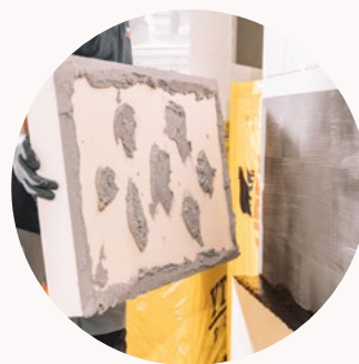
Bild 1: Auftragen des Bauklebers im Punkt-Wulst-Verfahren
