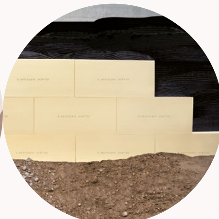
Verlegung im Verband
