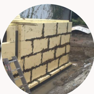
Verarbeitung der URSA XPS Dämmung bei drückendem Wasser
