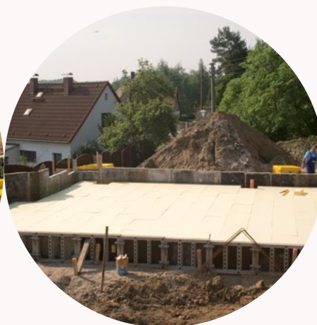
Im Verband verlegte URSA XPS Dämmung für ein Einfamilienhaus
