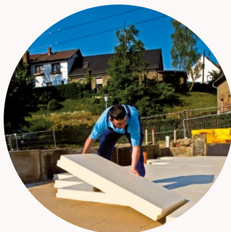
Verlegung der URSA XPS Dämmung auf der Sauberkeitsschicht
